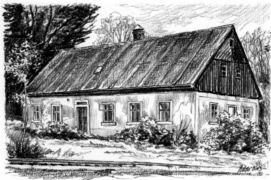
Stará škola po druhé světové válce již vůbec nebyla v dobré kondici. Postupně chátrala, až byla nakonec zbořena. Místo, kde stála, bylo zabráno pro rozšíření areálu Bytexu, který byl obehnan vysokým betonovým plotem. V popředí jsou koleje železniční vlečky.
