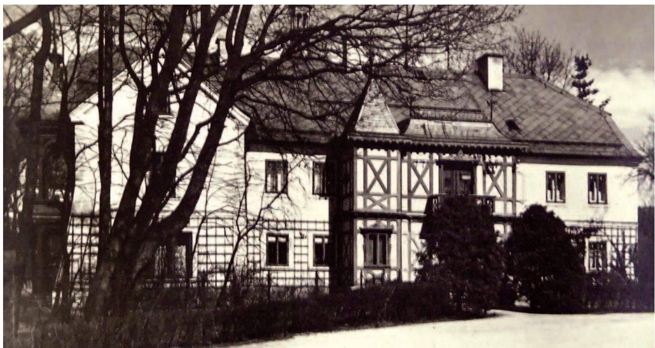
Vcelku výstavný dům č. p. 120 stával po pravé straně cesty vedoucí od kostela dolů k mostu. Ginzkeyův podnik v něm pronajímal byty svým prominentním zaměstnancům přilákaným až ze Saska: inženýru Adolfu Rechenbergovi a obchodnímu řediteli Gustavu Klunkerovi. Archiv Ondřej Marčák
