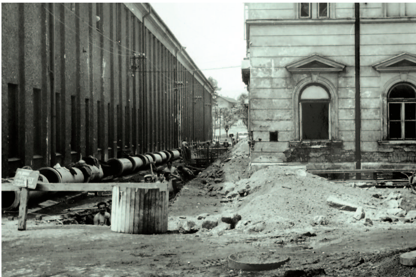
Budování kanalizace v Pobočné ulici v časech socialismu. Jídelna byla tehdy již v notně sešlém stavu. V roce 1974 prošel objekt rozsáhlou rekonstrukcí, kterou prováděli přímo pracovníci Bytexu. Vše se stihlo v tehdy jen těžko uvěřitelném termínu jednoho jediného roku a jídelna byla do provozu opět uvedena v dubnu 1974.
