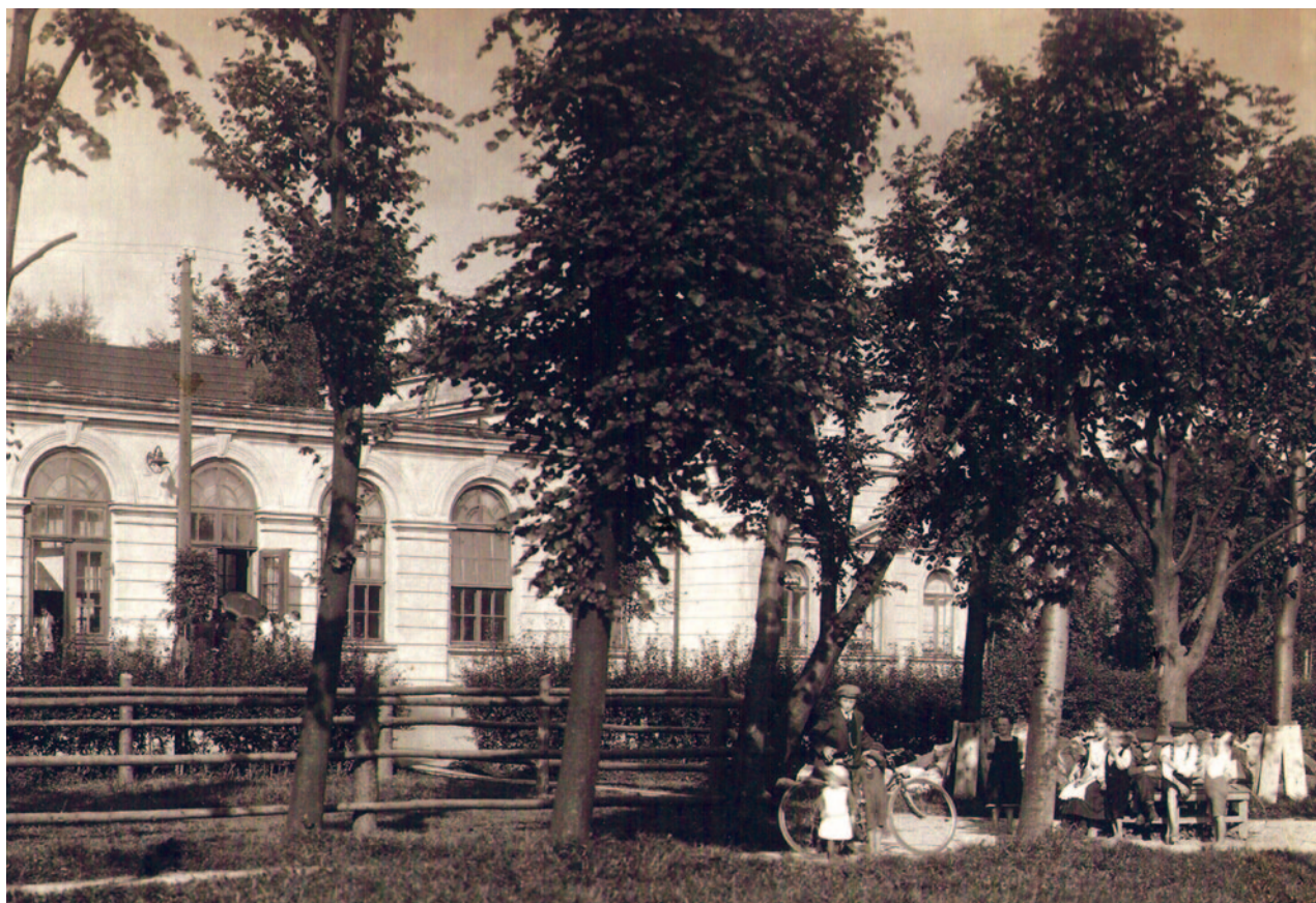
Jídelna, v době svého vzniku označovaná jako „Speisehalle“, byla postavena jako velmi pěkná stavba se zdobenou historizující fasádou plnou ozdob. Budovu tvořily dvě patrové části, které spojovala přízemní část s velkými okny, jež jsou dobře vidět na snímku pořízeném ještě před výstavbou haly naproti.
