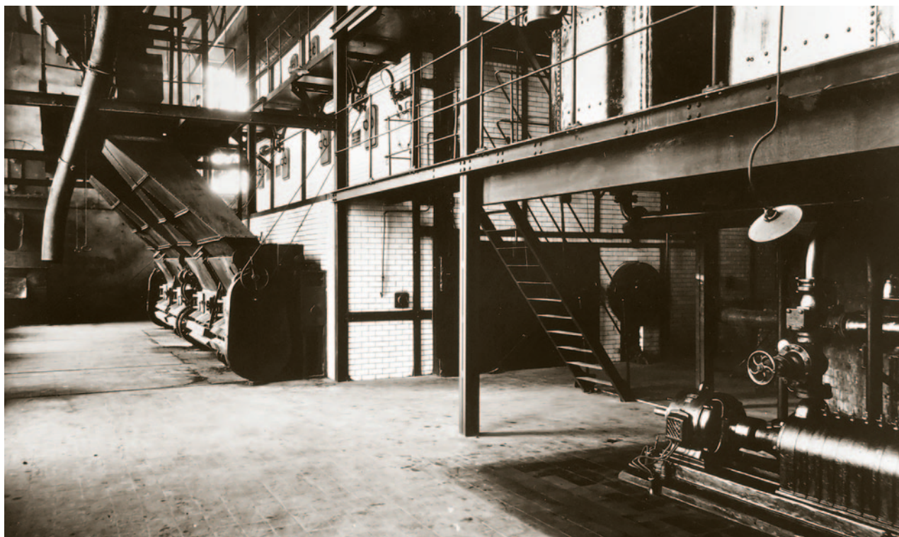
Kotlová hala ginzkeyovského energocentra v době krátce po svém vzniku na samém počátku Československé republiky. Šlo o zařízení na svoji dobu velmi moderní a navíc „oblečené“ do mimořádně velkolepého hávu architektury Leopolda Bauera. Archiv Ondřeje Marčáka
