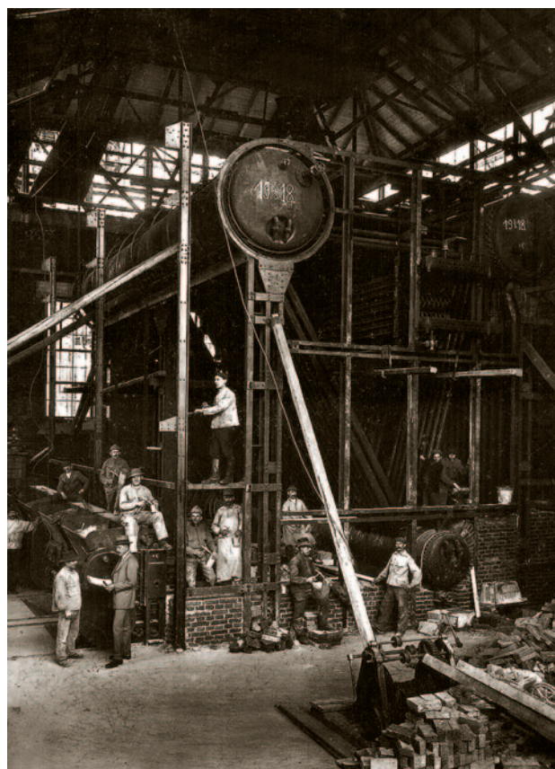
Vzácný snímek z výstavby kotlů; šlo o zděné konstrukce ze šamotu s vestavěnými bojlerý.
