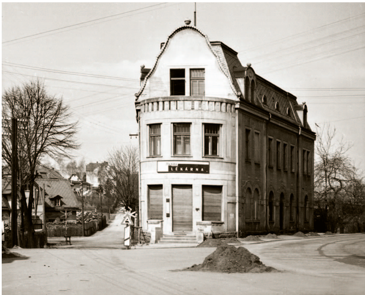
Na počátku 50. let 20. století již provozoval lékárnou národní podnik Medika, jehož název byl nově součástí vývěsního štítu lékárny. Tehdy ještě okolo nevedly tramvajové koleje; zato stavbu občas halil uhlelný prach ze skladů, do nichž vedla brána vlevo.
