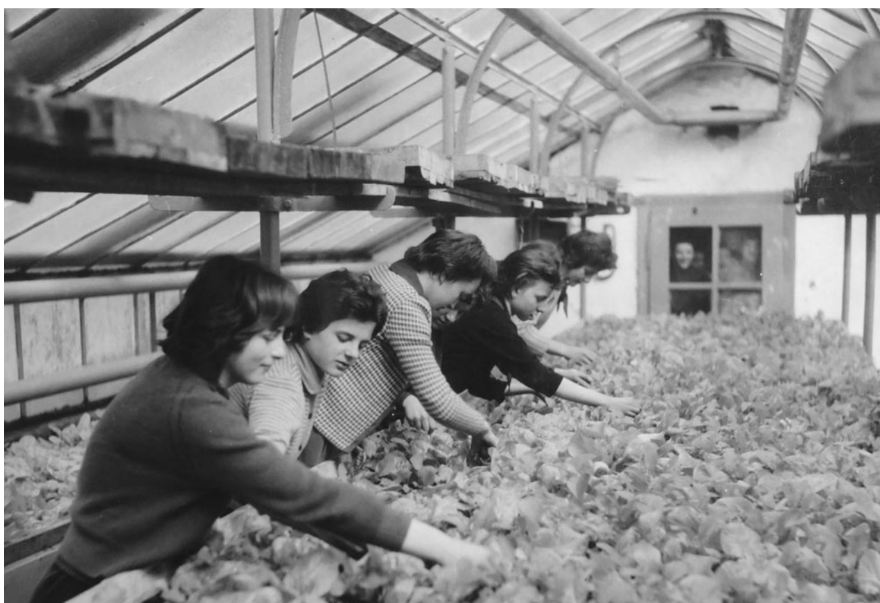
Pozemky u budovy bývalého sirotčince sloužily potřebám zahradnického střediska, které bylo využíváno i pro výuku žáků nedaleké základní školy. Objekt tak byl léta neodmyslitelně spojen s lesknoucími se střechami několika skleníků. Archiv ZŠ Vratislavice nad Nisou
