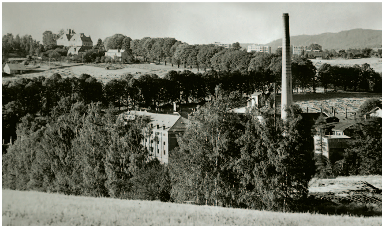
Při pohledu ze Strážného vrchu na dominantu Nové Rudy, budovu dnešní umělecké školy, je patrné, že ještě nebyla započata výstavba rozsáhlého komplexu budov závodu SČVK. Avšak na pozadí je již ve výstavbě sídliště Králův Háj. Archiv Ondřeje Marčáka
