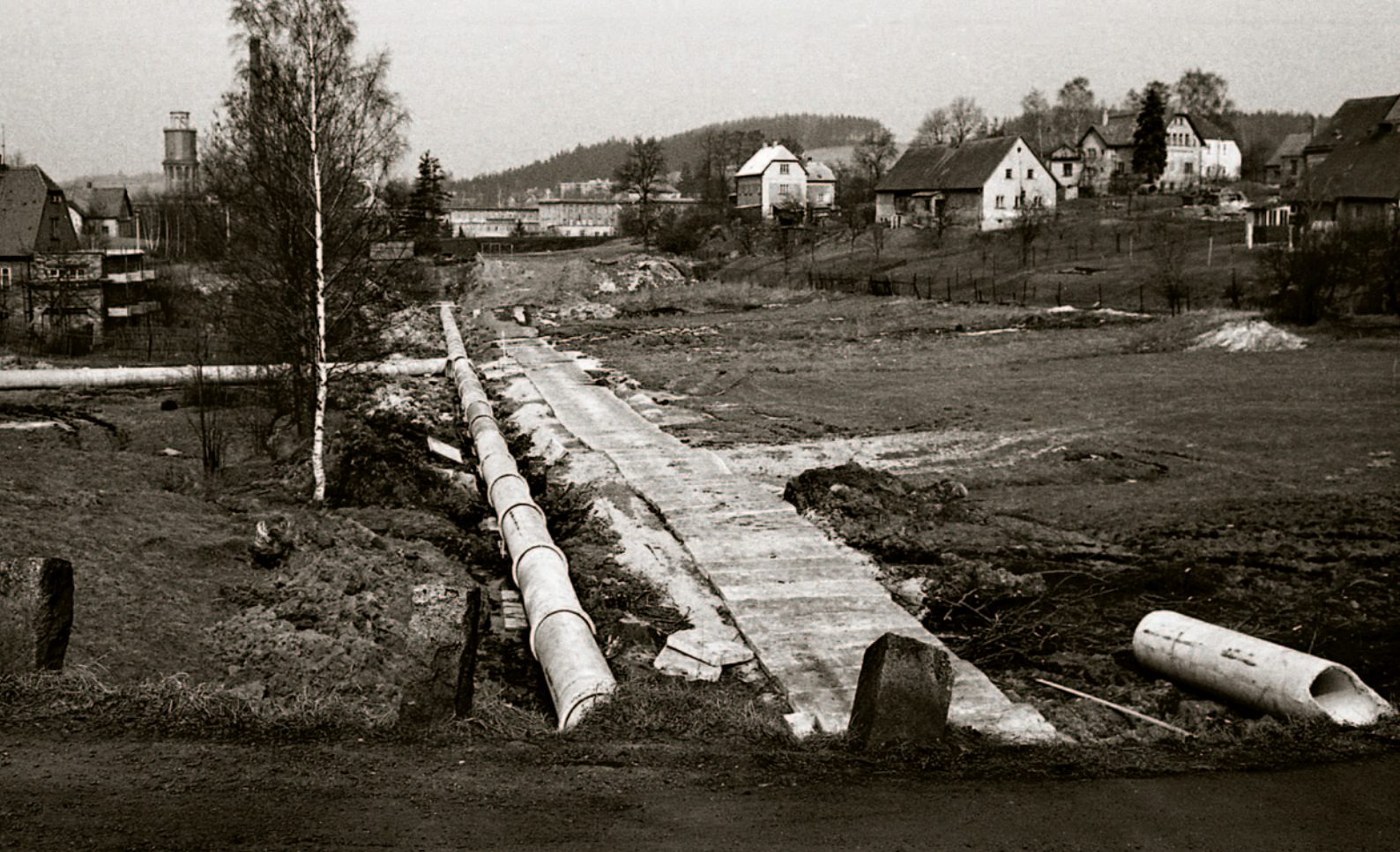
Fotografie horní části údolíčka pod hospodou U Prasete. Potůček byl v 70. letech i v této části pod ulicí Dlouhomostecká spoután do betonových rour. V levé části je dobře vidět i zaústění vodních přepadů z rybníčku v ulici Na Rozcestí. Archiv Ondřeje Marčáka
