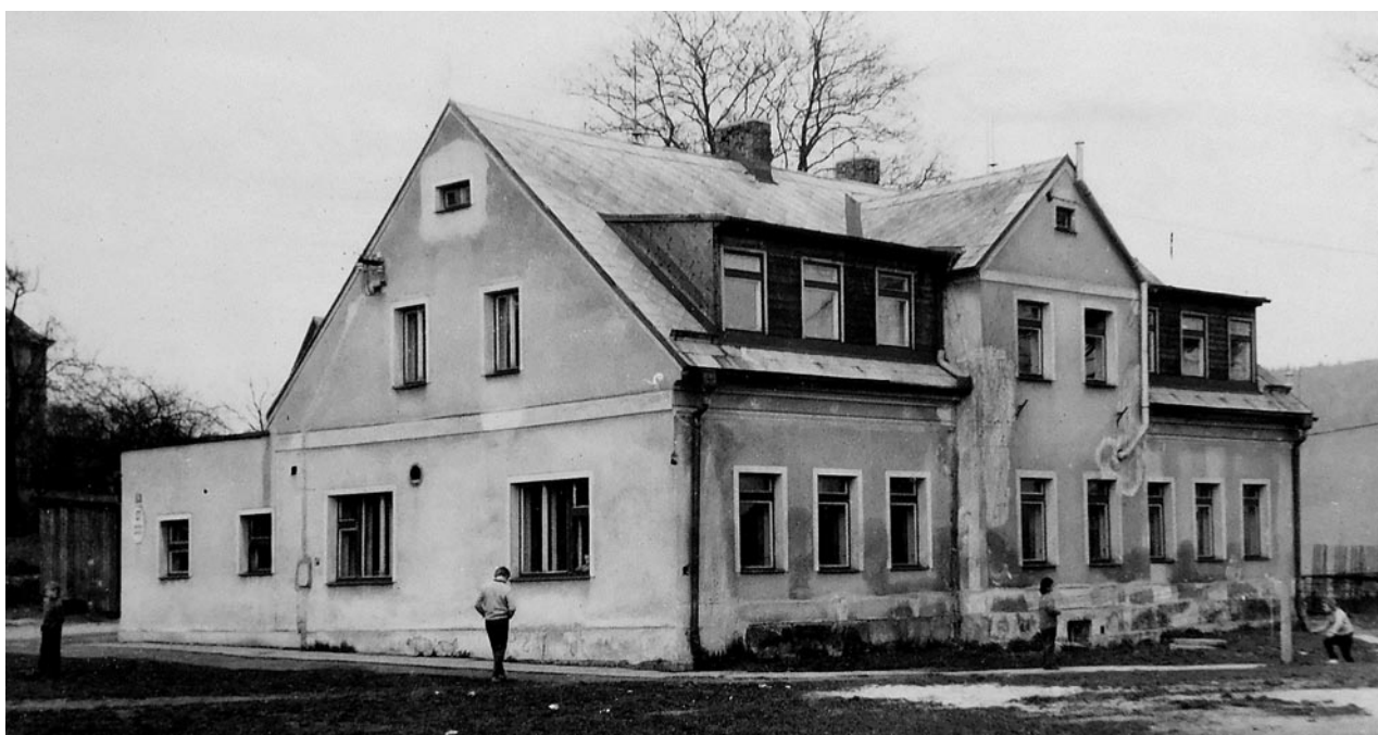
Obecní budova č. p. 52 stávala v zahradě za vřatislavickou školou, právě v místě dnešního sportovního zázemí. Po vzniku republiky do ní byla umístěna česká škola; od roku 1956 začala sloužit jako družina mládeže. Při přestavbě školy a stavbě školky byl objekt zbořen.
