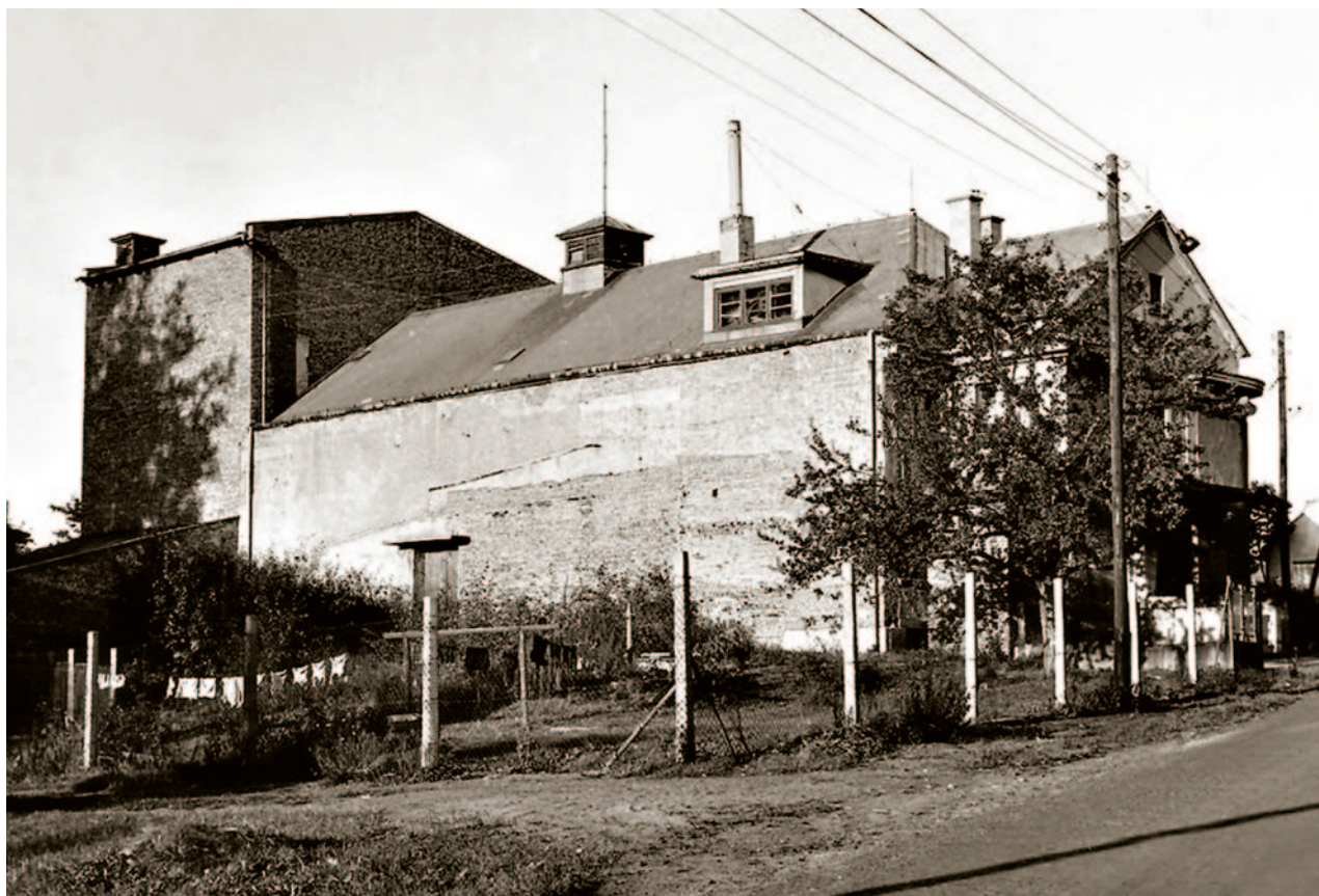
Přestavba sešlé tělocvičny na opravdové divadlo byla, díky podpoře kobercárny, poměrně velkorysá. V zadní části bylo zřízeno jeviště s moderní technikou a sametovou oponou; před ním byla jáma orchestřiště a v bývalém sále tělocvičny vzniklo stupňovité jeviště. Nechyběl ovšem ani foyer se šatnou a bufetem. Archiv Ondřeje Marčáka
