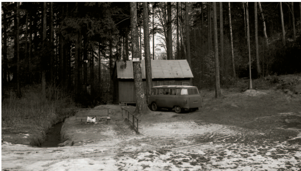
Zázemí stavby můstku tvořila obyčejná bouda u potoka, na snímku s půvabnou dodávkou značky Barkas. Po skončení stavby byla cílem nájezdů vandalů a Ondra Marčák vzpomínal, jak byly vratislavické děti opakovaně školním rozhlasem varovány, aby se místu vyhnuly. Archiv Stanislava Slavíka
