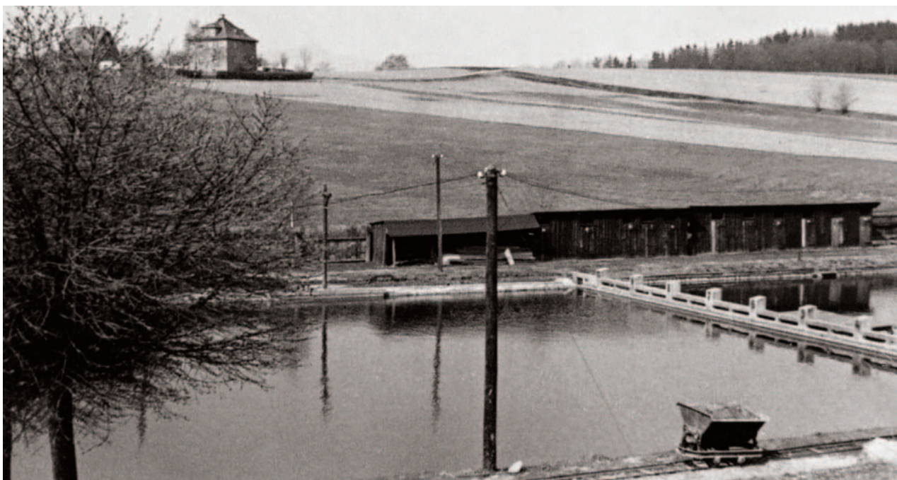
Kvůli přesunu materiálu při přestavbě bazénu byla zřízena i kolejová trať. Nahoře ještě nejsou domy sídliště v Náhorní, ale jen dva rodinné domy tehdy patřící Ochotným a Maxovým.
