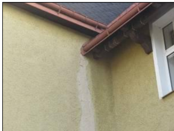
foto 22 exteriér, poruchy fasády (4)
