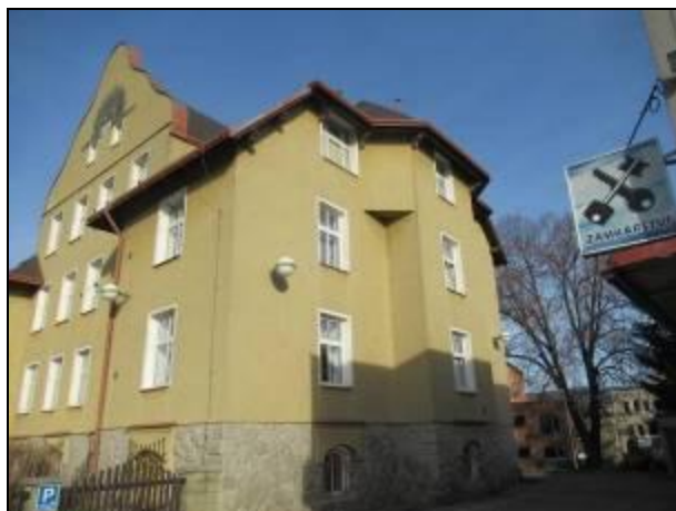
foto 6 exteriér, uliční (západní - vlevo) fasáda a boční (jižní - vpravo) fasáda
