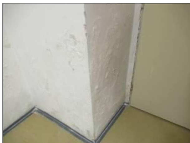
foto 26 interiér, účinky vlhkosti v 1. PP (3)
