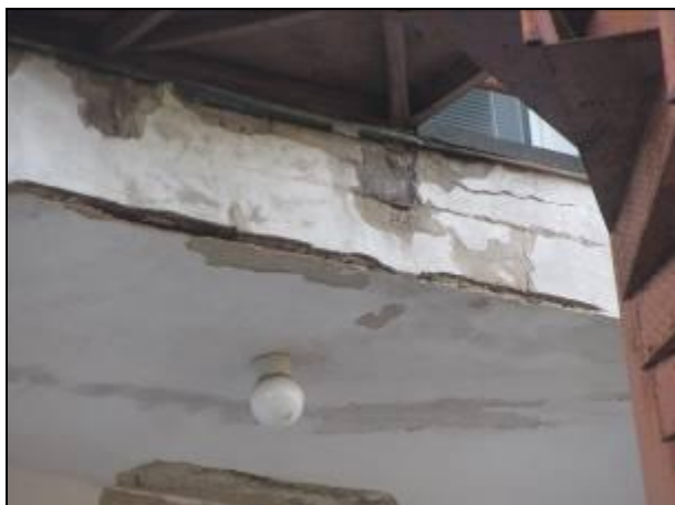
foto 21 exteriér, poruchy fasády (3)
