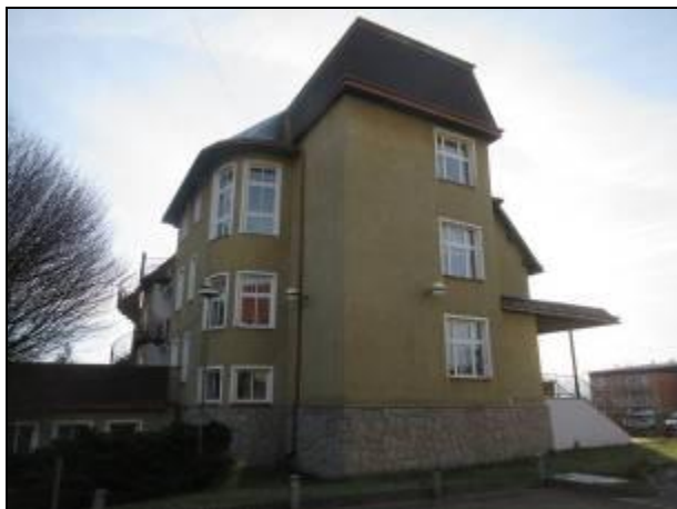
foto 3 exteriér, boční (severní - vpravo) fasáda a zadní (východní - vlevo) fasáda
