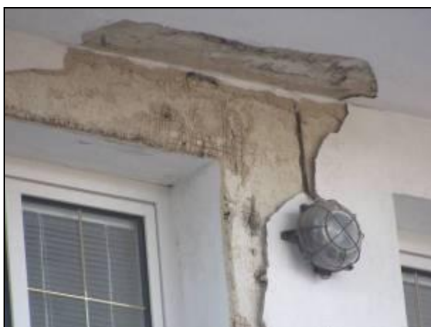
foto 19 exteriér, poruchy fasády (1)
