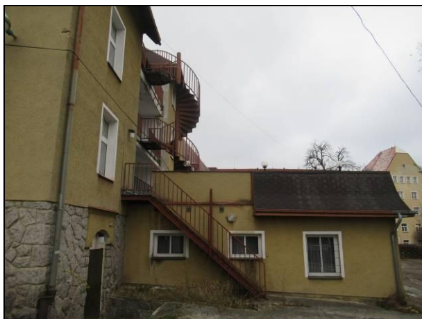
foto 17 exteriér, detail požárního schodiště vzadu
