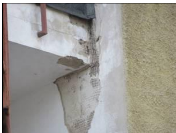
foto 20 exteriér, poruchy fasády (2)
