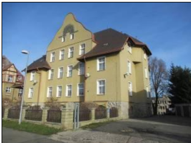
foto 1 exteriér, uliční (západní - vlevo) fasáda a boční (jižní - vpravo) fasáda
