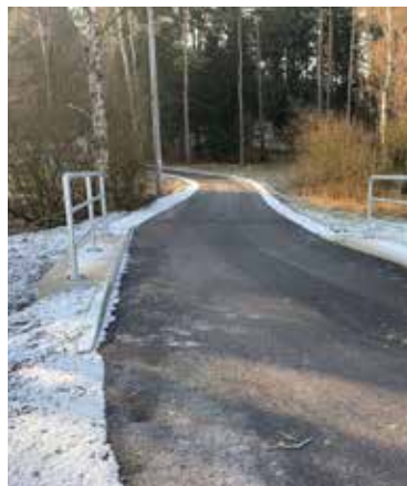
Opravený most a silnice v Sedmidomkách
