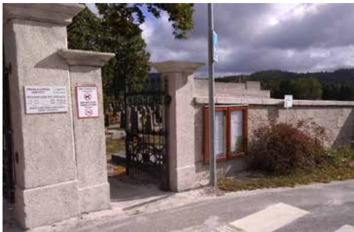
Stav po čištění
