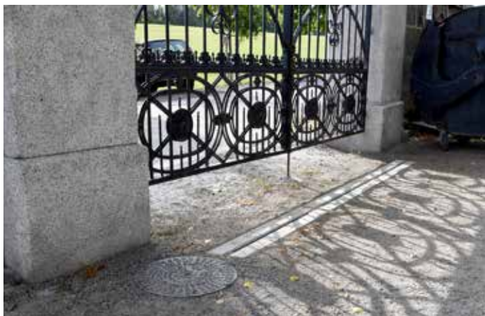
Nová odvodňovací drenáž
